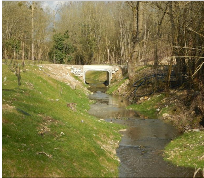
Figure 33 : Photo d'un pont-cadre réalisé par le syndicat de la Nonette (Source : SISN)
