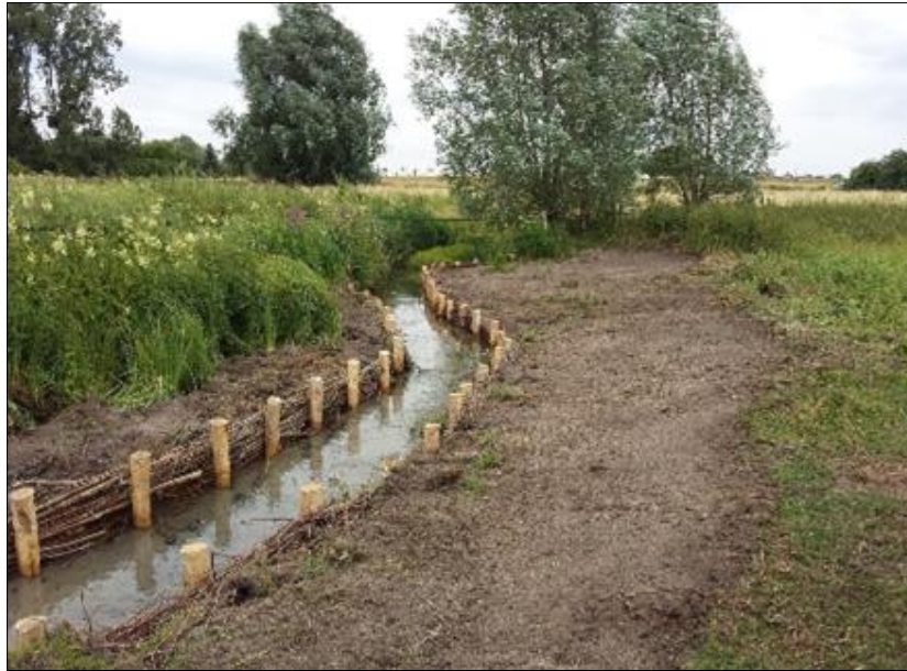
Figure 20 : Photo d'une restauration de berge en fascinage (SITRARIVE)
